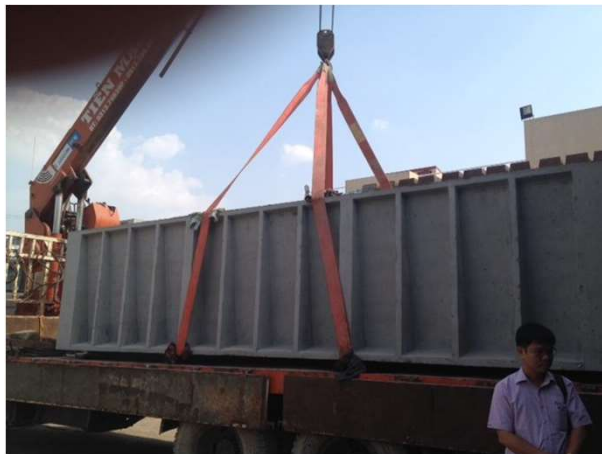
Công trình: Thùng chìm Công ty TNHH Hoàng Vũ HL Năm XD: 2013
