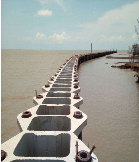
Hạng mục: Kè phá Sóng Khu vực ven biển Kinh Mới – Đá Bạc, Tỉnh Cà Mau Công ty CPKH công nghệ Việt Nam Năm XD: 2018
