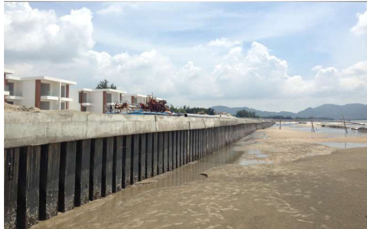
Hạng mục: Cừ giữ cát - Rừng Dương, Phú Quốc Công ty CP đầu tư và phát triển Công nghệ NUCETECH Năm XD: 2016
